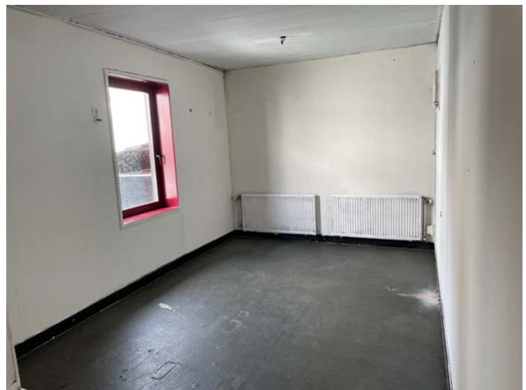
Bovenetage aanbouw links
