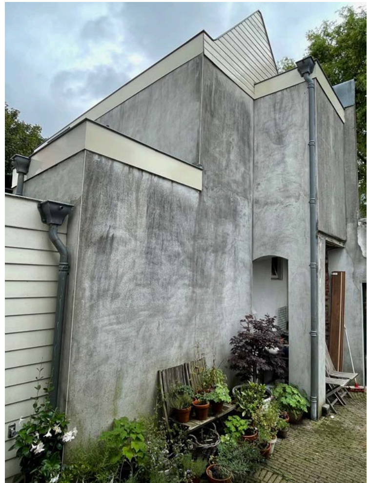
Buitenzijde aanbouw vanuit tuin 79
